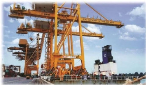
ติดตั้ง ณ ท่าเรือกรุงเทพ (ถ่ายจากภาพจริง)
