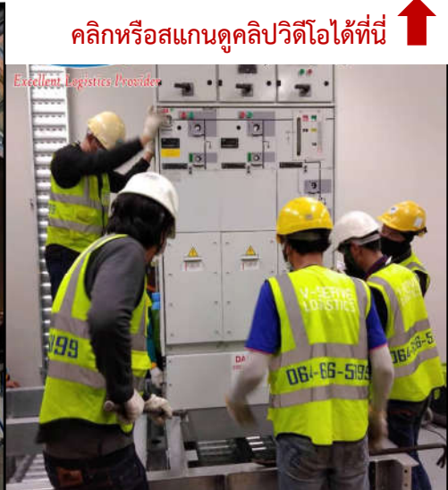
การติดตั้งอุปกรณ์ไฟฟ้าและแผงกันสถานีรถไฟ ปี 2563/2564 จำนวนประมาณมากกว่า 80 สถานี
